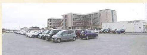
増設した駐車場
